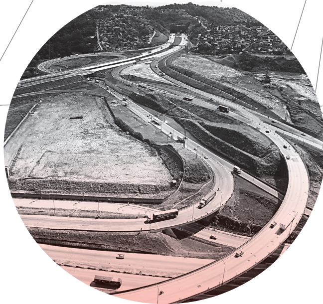
Rodoanel trecho Sul São Paulo
